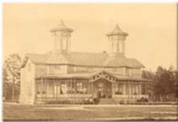
Hangon Kasino juurivalmistuneena 1879, jolloin sitä kutsuttiin Kaivohuoneeksi ja Seurahuoneeksi. Seinät ovat vielä laudoittamattomat. Hangon museon kuvaarkisto.
